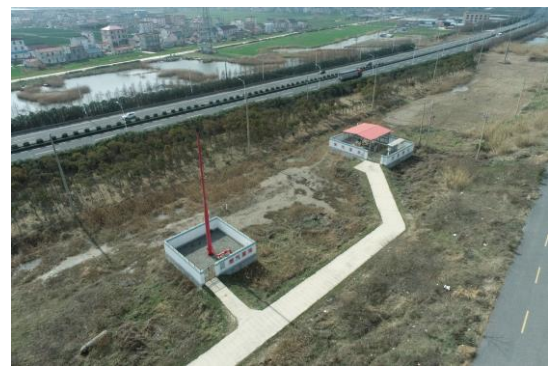
周边道路 G328、堤顶公路及水塘
